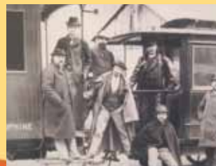
Inauguration des VFD - 1894
